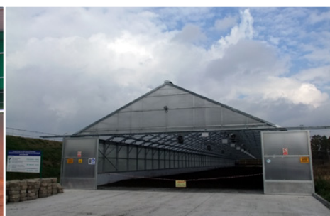
Zakład Wodociągów i Kanalizacji Myszków – hala odbioru suszu
