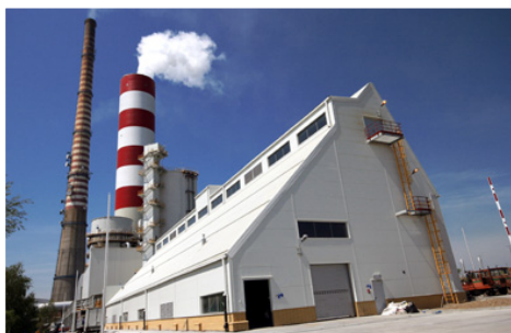
Elektrownia Rybnik – Instalacja odsiarczania spalin
